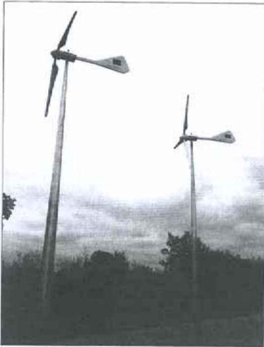
El complejo cuenta también con dos mini-aerogeneradores. / ECB
