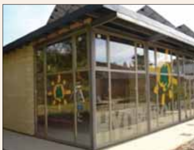
Figura 8. Vista del edificio técnico auxiliar con cubierta fotovoltaica.
